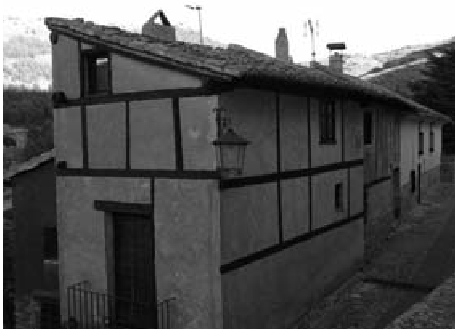
Figura 20. La estructura de la vivienda doméstica, conformada con entramados de madera, tapial y yeso, era de factura muy modesta.
