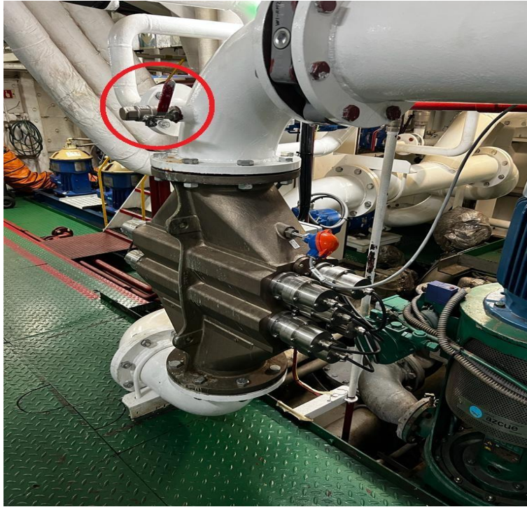
Ilustración 10 Toma de muestra para inspección Fuente: Elaboración propia
