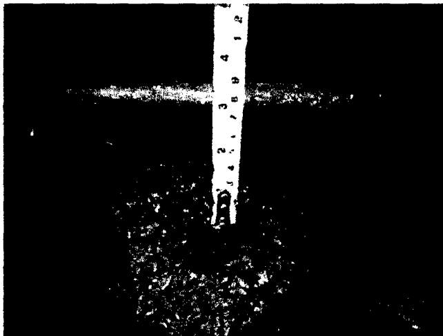
Foto 20.-Medición del asentamiento del concreto fresco
