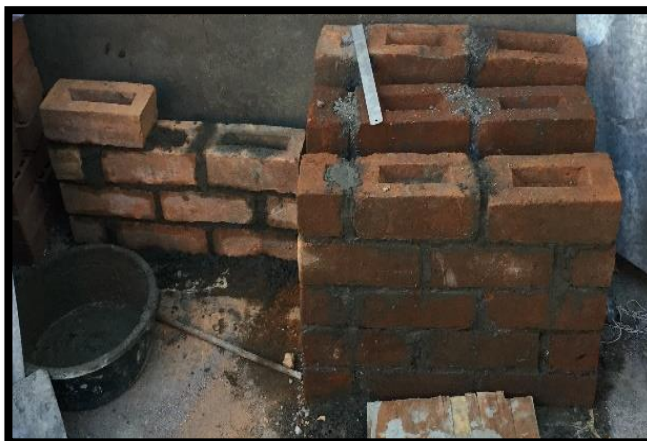
Muretes con ladrillos de arcilla
