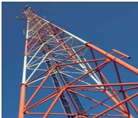
**Figura 4:** torre de telecomunicación auto-soportada triangular
