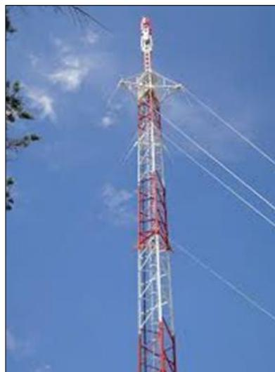
**Figura 7:** torre de telecomunicación tipo mástil
