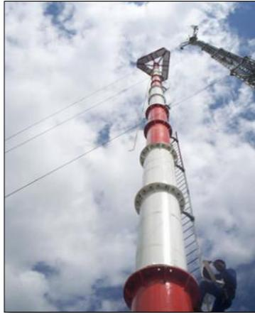
**Figura 6:** torre de telecomunicación tipo monopolo
