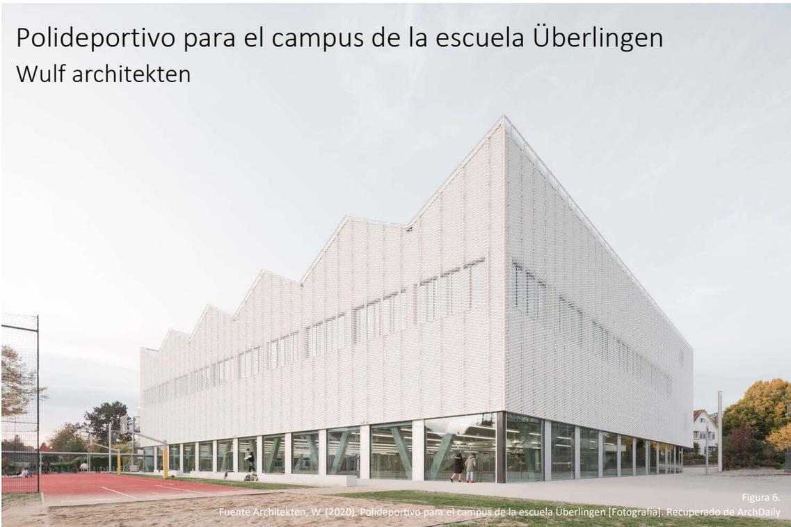
Volumen cerrado y de mayores dimensiones sobre primer nivel estructurado mediante pilares y acristalado, que guarda mayor relación con el nivel de áreas verdes y deporte exterior.
