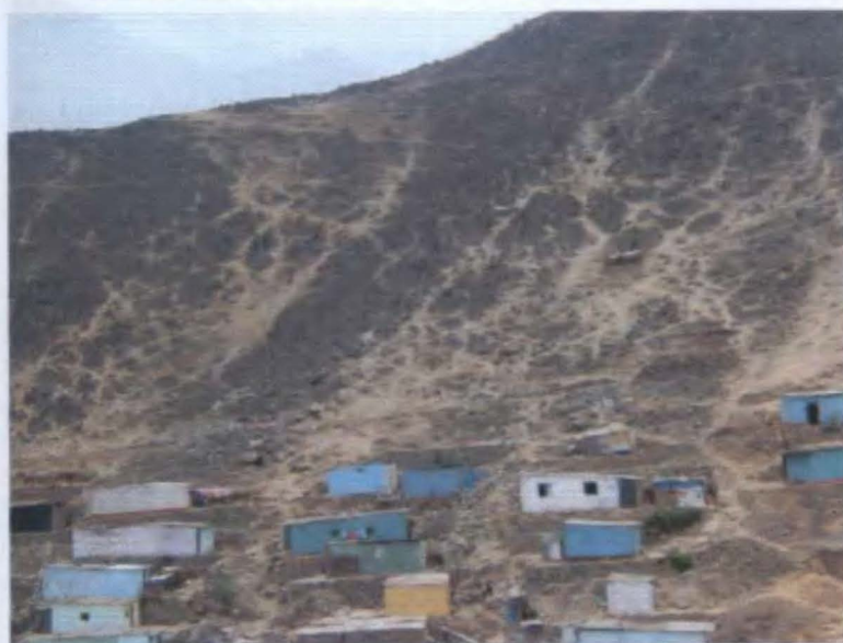
Foto N°9. Obsérvese los depósitos coluviales ( manchas negras en la ladera), a la margen derecha de la quebrada, los cuales son producto de la caída de rocas, acumulados en las depresiones de la ladera
