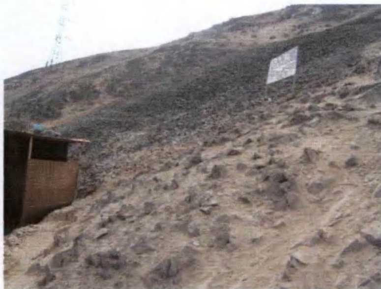
Foto N° 5. Obsérvese los fragmentos de rocas acumuladas en la manzana "A", producto de la caída de rocas.
