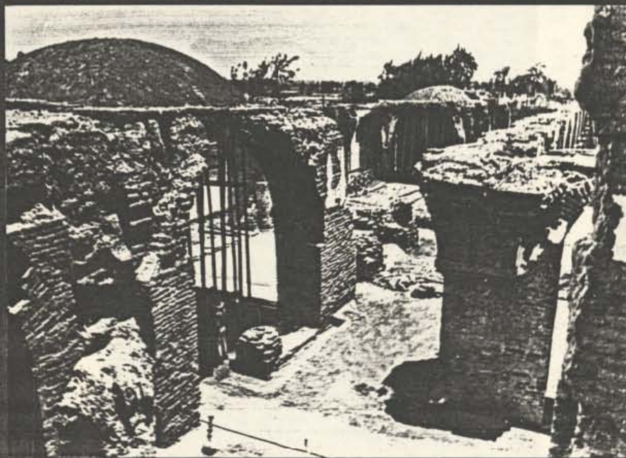
VISTA DESDE EL CLAUSTRO DE LA PORTERIA, AN- TES DE LA INTERVENCION DE "ARIES".
