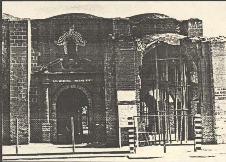
VISTA EXTERIOR DE LA 1ª CAPILLA DE LA NAVE + LATERAL DERECHA, DE LA IGLESIA ANTES DE LA INTERVENCION DE "ARIES" Y COASE (ZONA DEL MURO TESTERO).
