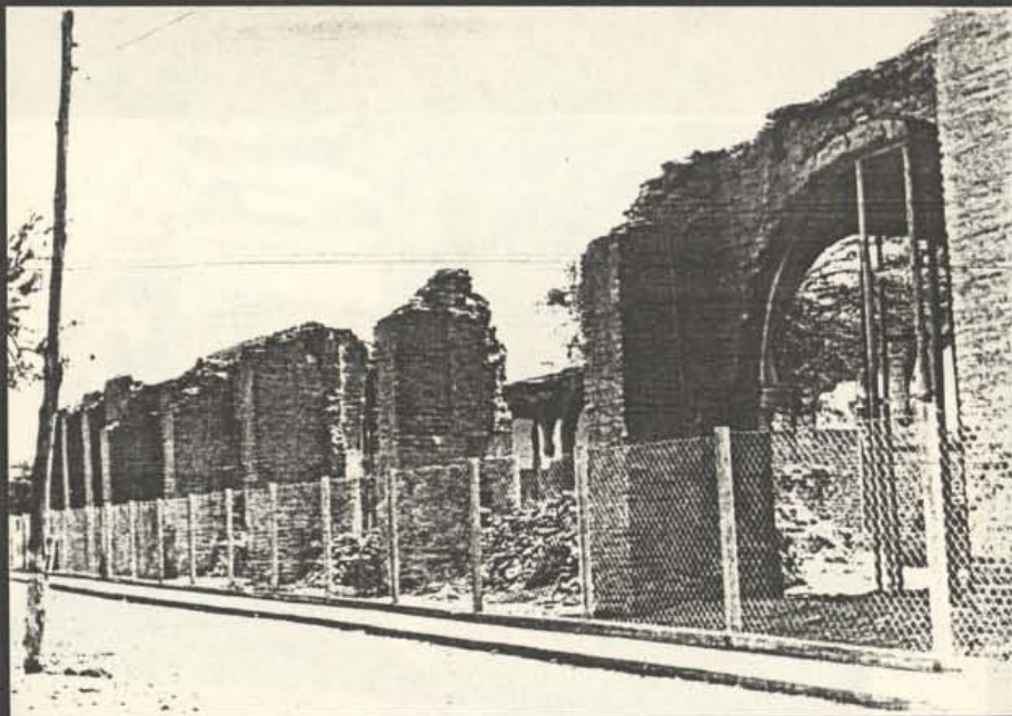
VISTA DESDE EL EXTERIOR , DE LA PORTERIA DEL CONVENTO ANTES DE LA RESTAURACION DEL MURO - DE ADOBE DE CIERRE, CON LA VEREDA EXTERIOR - CONSTRUIDA ANTES DE LA INTERVENCION DE "ARIES".
