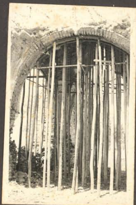
VISTA DE BOVEDA 3 Apuntalamiento y cimbras
