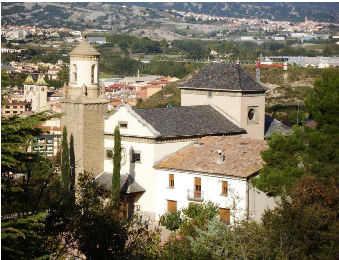
Vista general del santuari de la Mare de Déu de Rocaprevera.
