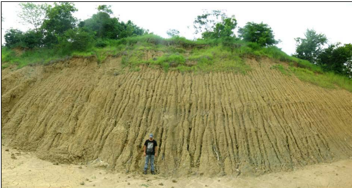
Figura 11. Aspecto de los movimientos en masa tipo deslizamiento rotacional presentes en el costado Suroriental del "volcán de lodo" Pueblo Nuevo. Nótese la corona y escarpes de deslizamiento en la parte superior y la formación de surcos en la parte media y baja de la misma.
