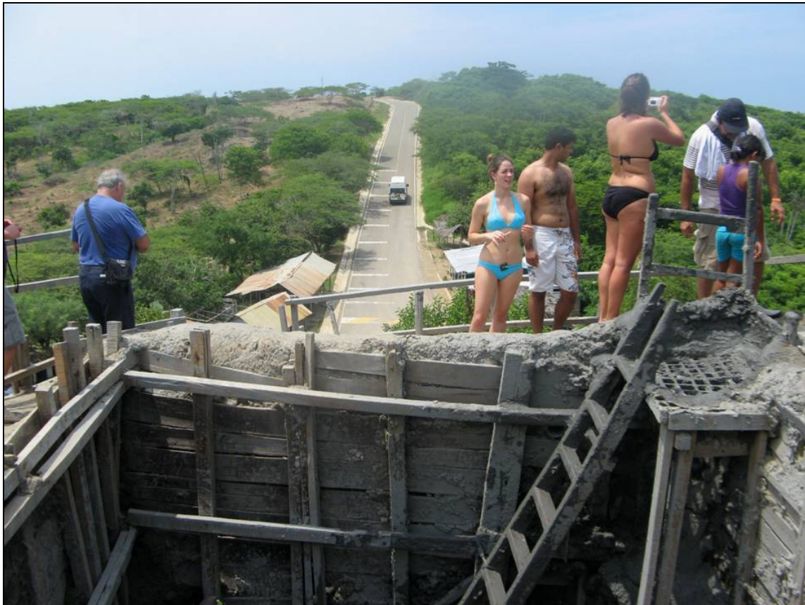
Figura 12. Vista hacia el Occidente de la zona de la parte alta de la boca u oído turístico tipo A en forma de cono del Totumo. Nótese las empalizadas elaboradas para estabilizar la boca internamente y las escaleras para acceder al cono. Al fondo cima principal del “volcán de lodo” El Totumo y la vía construida para tener acceso al cono turístico.
