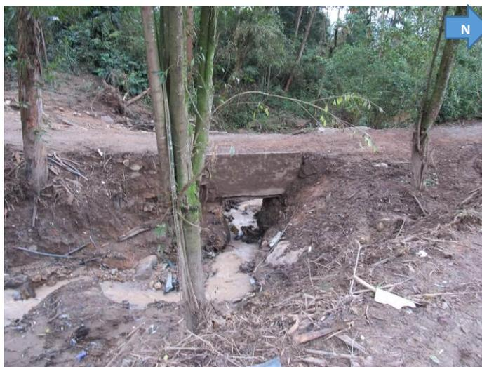
**Figura 12.** Detalle sección box coulvert y márgenes de la quebrada afectados por remoción de material vegetal.
