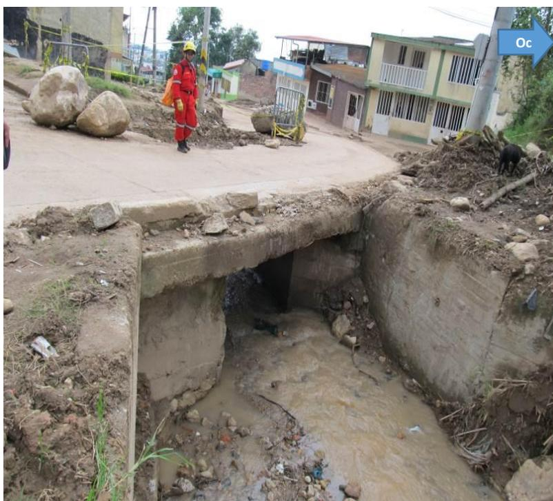
**Figura 13.** Detalle sección box coulvert.
