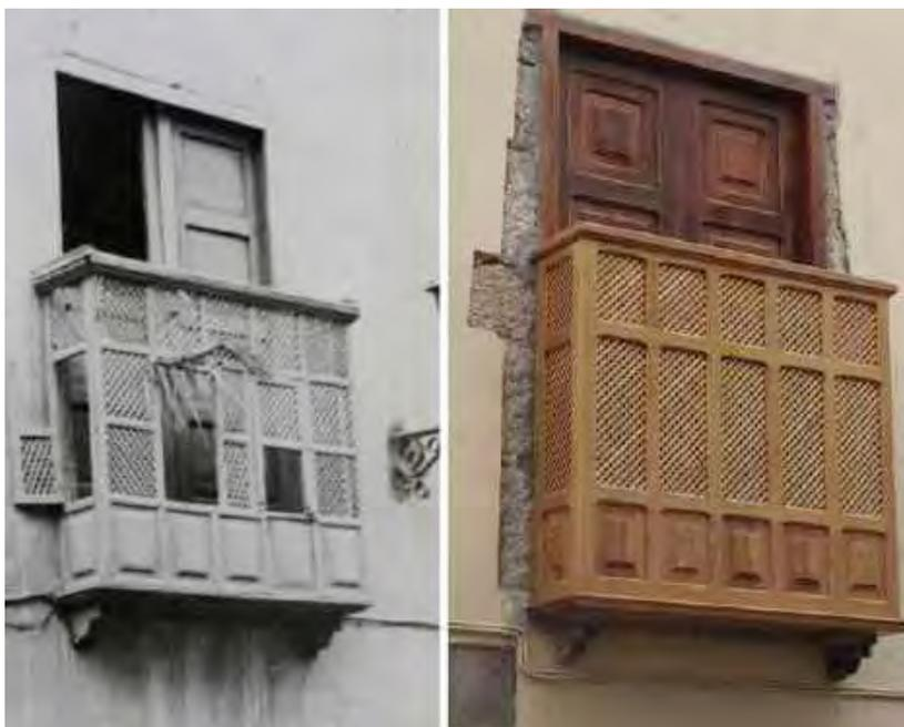
Calle del Rosario, número 8, en Vegueta. Sustitución del balcón de celosías por una copia sin valor que ni siquiera guarda el diseño del original
