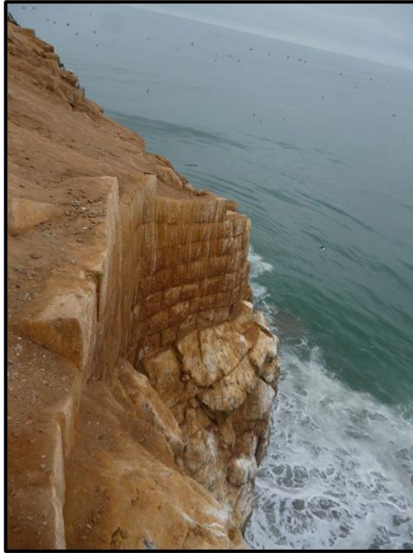
Foto 2. Muro con sillería imperial, ubicado en la parte media del acantilado del cerro Centinela
