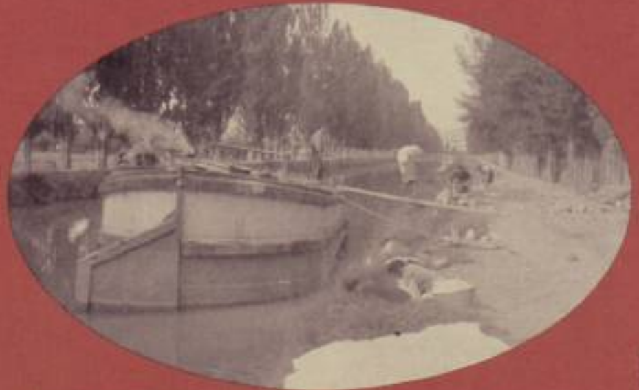
Lavanderas en el Canal y barca de carga descargando materiales
