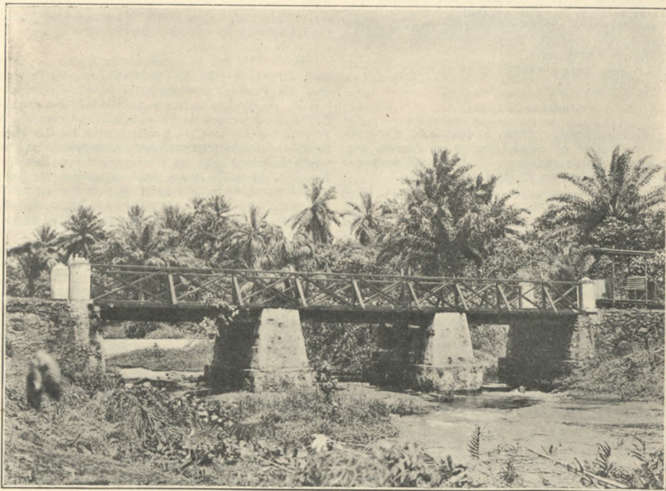
5. Thomé. — Ponte sobre o rio «Manuel Jorge»
