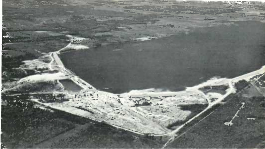
La central hidroeléctrica Carillon sobre el río Ottawa entró servicio en 1962. Su capacidad final, una vez completamente instalada, será de 840.000 hp.
