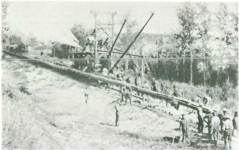
Construcción del ferrocarril transcontinental—cordón umbilical de la unidad política.
