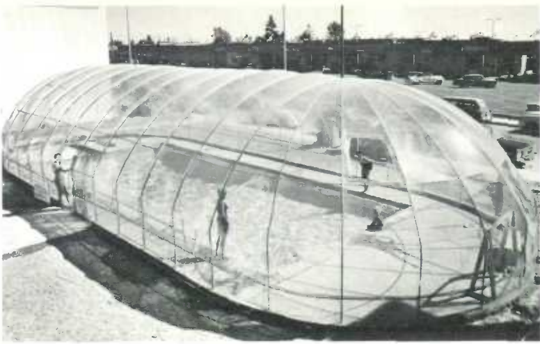
Se están encontrando continuamente nuevos usos para las hojas de plástico. Esta cúpula de tubo de aluminio cubierta de plástico de vinilo, protege a los nadadores de los elementos y prolonga la estación de natación.
