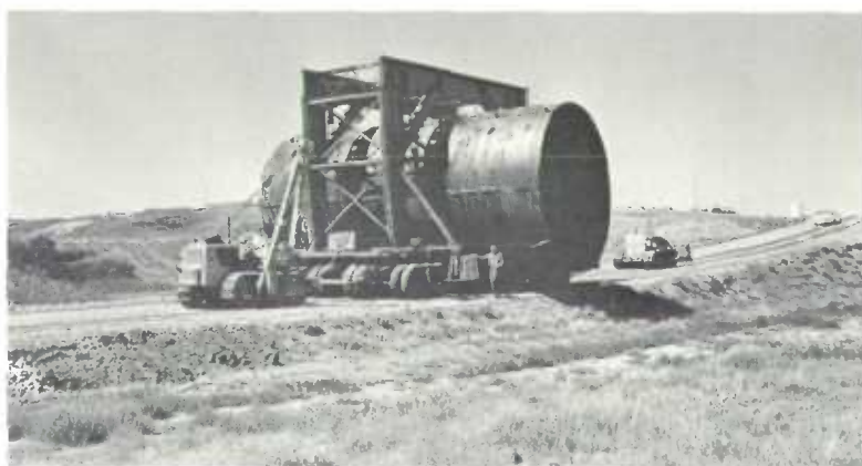
Se emplea equip especial para transportar un revestimiento de tunel al emplazamiento de una presa, en el sur de Saskatchewan, donde avanza la construcción de un proyecto de irrigación y electricidad de 184.000.000 dólares, financiado conjuntamente por los gobiernos federal y provincial.
