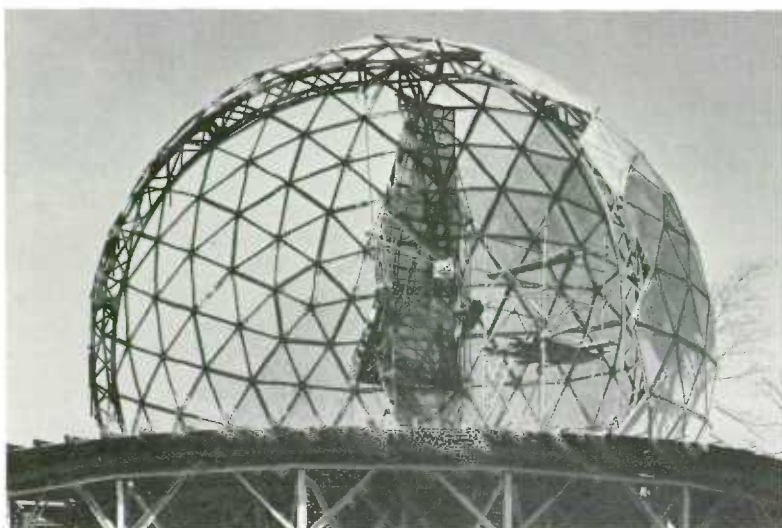
Esta cúpula de esponja de goma rígida que bien pudiera ser la primera del mundo en su clase, recubre las antenas de radar, protegiéndolas, pero no impidiendo el paso de las ondas radiales y los rayos de radar.
