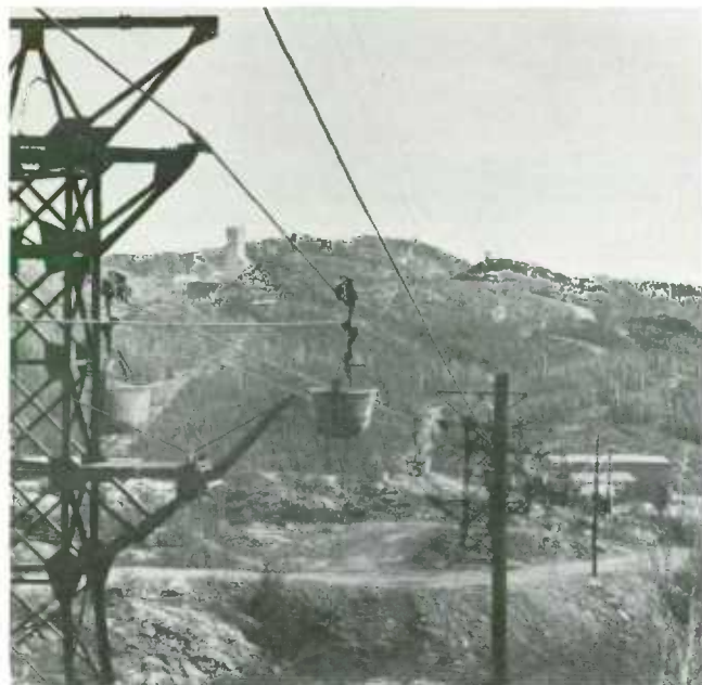
Un transportador aéreo de 3 millas que recorre 1\frac{1}{4} bajotierra a una profundidad de 2.000 pies y 1\frac{3}{4} al aire libre, transportando mineral a la planta en baldes de 3 toneladas.
