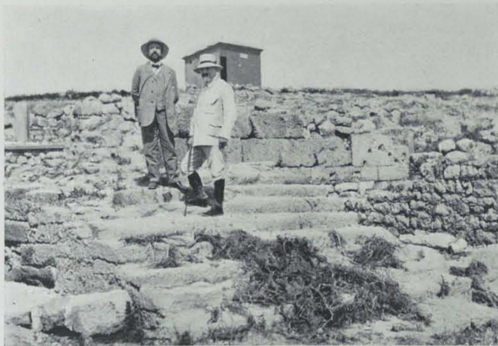
Fig. 26. — Escalinata de acceso al recinto de los templos. — Época helenística. Piedra arenisca bien tallada y a veces enlucido de cemento
