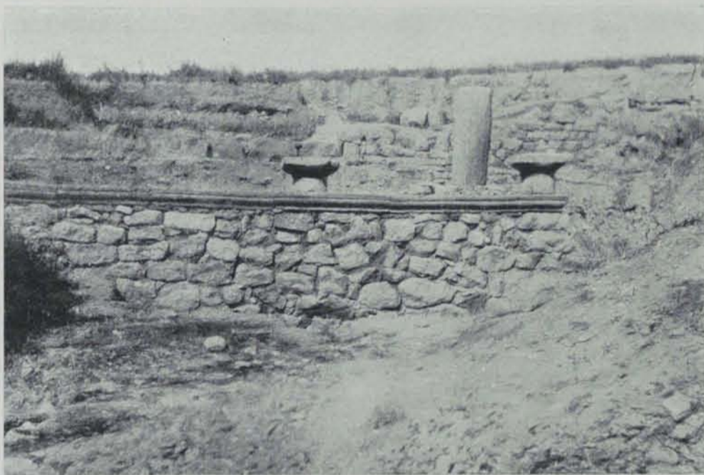
Fig. 27. — Basamento de un edículo de época romana. — Sillarejo irregular
