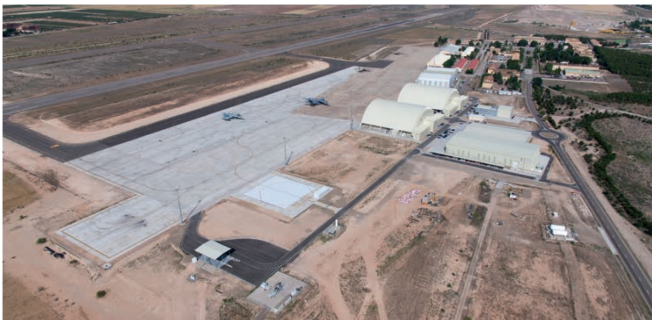
Imagen actual de la zona de Valenzuela donde se aprecian las nuevas infraestructuras (hangares, edificios para simulador y almacenes) y la ampliación de la plataforma de aparcamiento, para albergar los T-23
