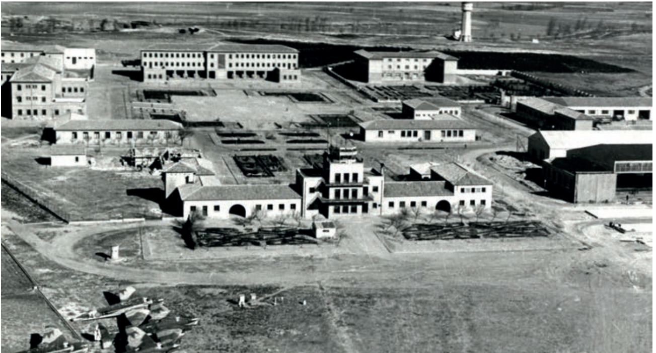
Vista de las instalaciones de la zona de Valenzuela a mediados de los 50. Se aprecian los He-111 del 14 Grupo y las obras de asfaltado del nuevo aparcamiento de aviones
