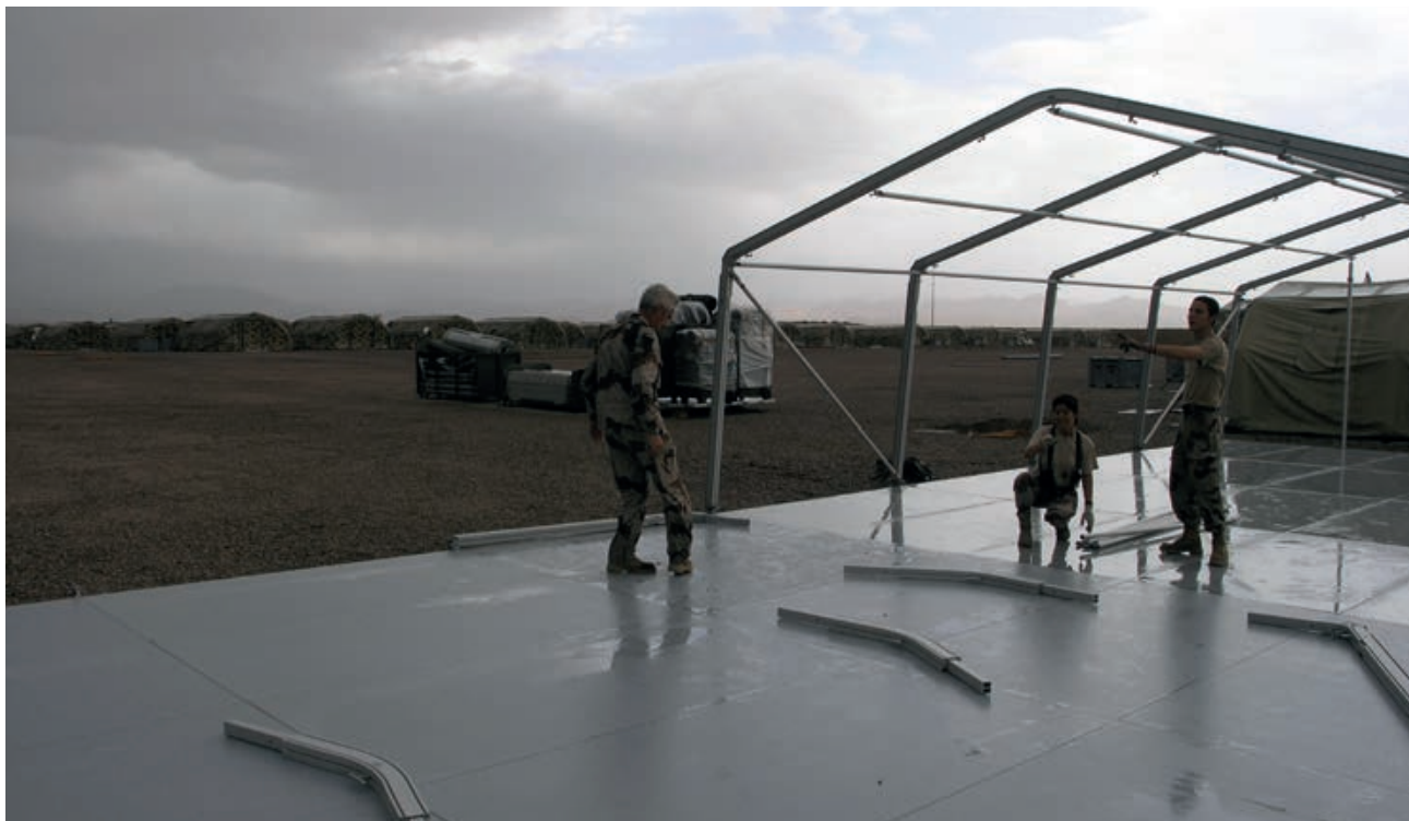
Instalación de las «tiendas» que alojarían el Role 2 de Herat
