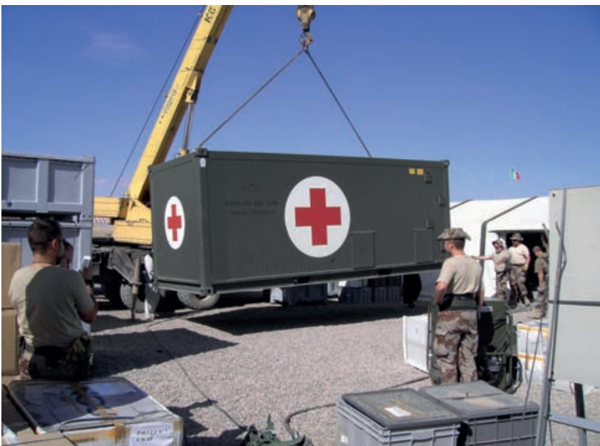
Contenedor de carga (ISO 20x8x8 ft) plomado y adaptado como estación de radiología digital. Se utilizó hasta el final de la misión
