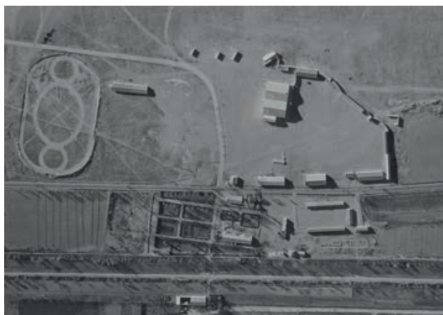
Instalaciones del Acuartelamiento Sanjurjo en diciembre de 1954
