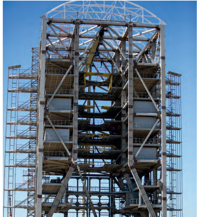
Futura plataforma de lanzamiento
