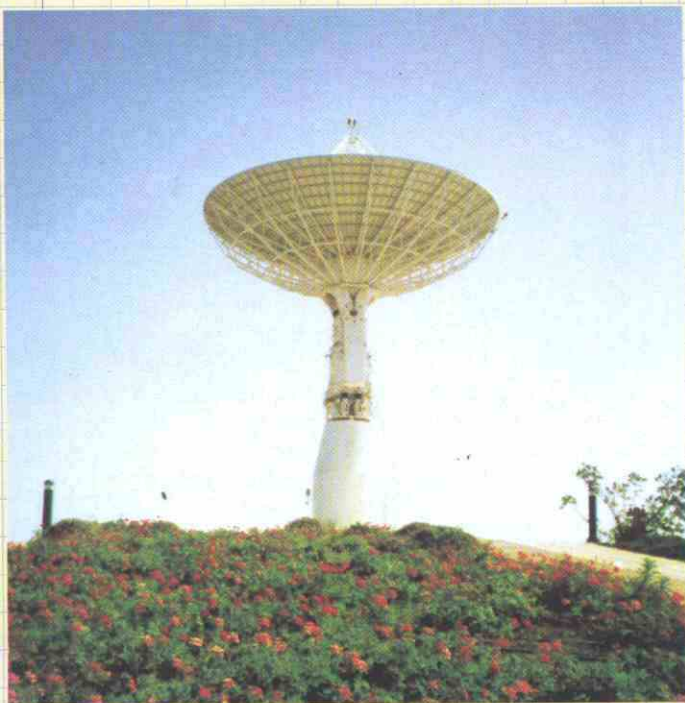
Antena de recepción del C.R.I.E. Maspalomas.
