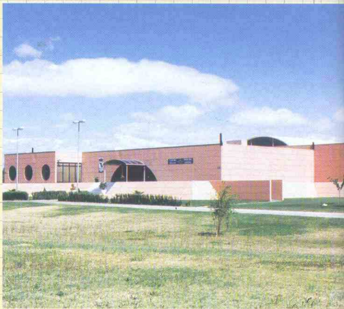
Vista general del edificio C.P.H.E.
