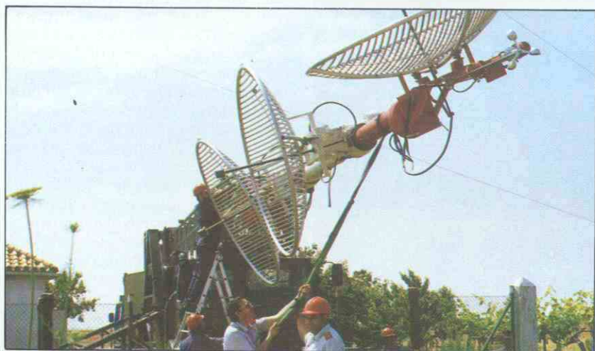
Despliegue Unidad Repetidora de MW en la Estación de Vicálvaro.
