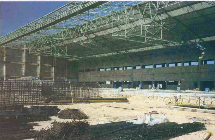
Detalle de la estructura del mismo hangar de la fotografía superior.
