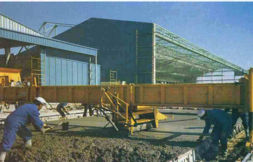
Operación de hormigonado de losas en la pavimentación de un estacionamiento.
