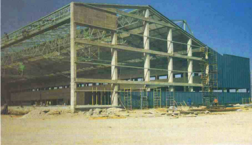
Estructura lateral de un hangar en construcción para la Maestranza de Albacete, se destinará a mantenimiento del avión CL-215.
