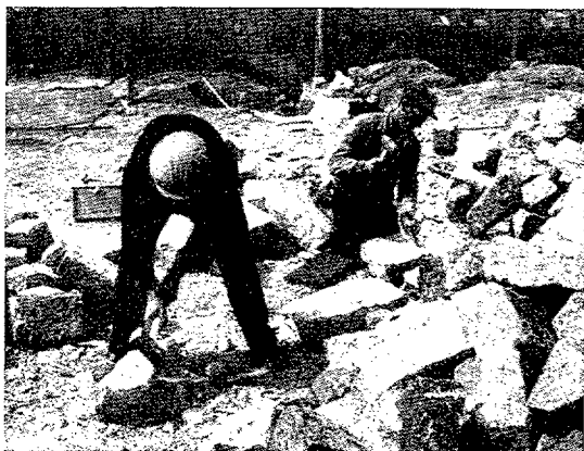
Canteros españoles construyen los edificios de la Estación de España próxima a El Escorial.
