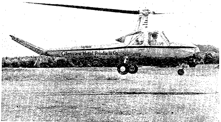
En Nueva Jersey se ha probado el primer helicóptero construido para fines civiles exclusivamente. Se trata del helicóptero Dooley, del que se dice será tan fácil de tripular como un coche de turismo.
