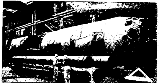
Instalación del túnel cilíndrico de 25,9 metros que une los compartimientos delantero y de cola.
