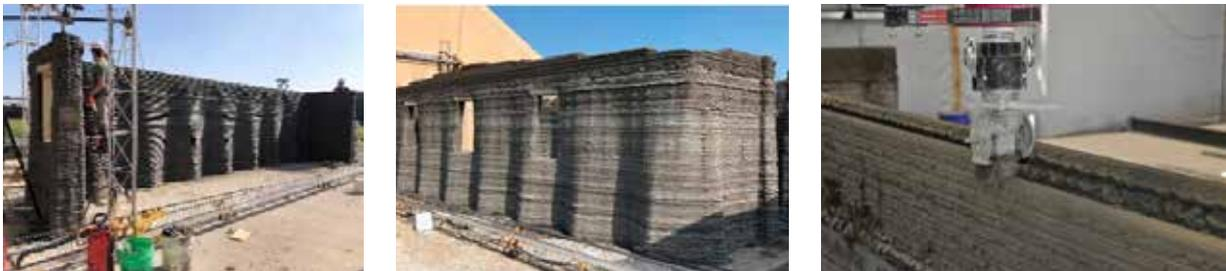
*Barracones de hormigón proyectado con impresora 3D en el marco del programa estadounidense "Automated Construction of Expeditionary Structures" (2017)*
