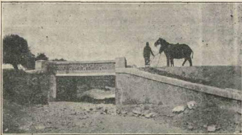
Vista de un pontón organizado con losa de cemento armado.
