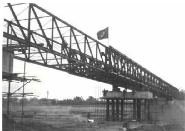
*Lanzamiento puente HG FFCC*
