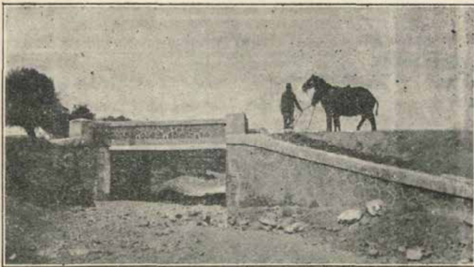
Vista de un pontón organizado con losa de cemento armado.
