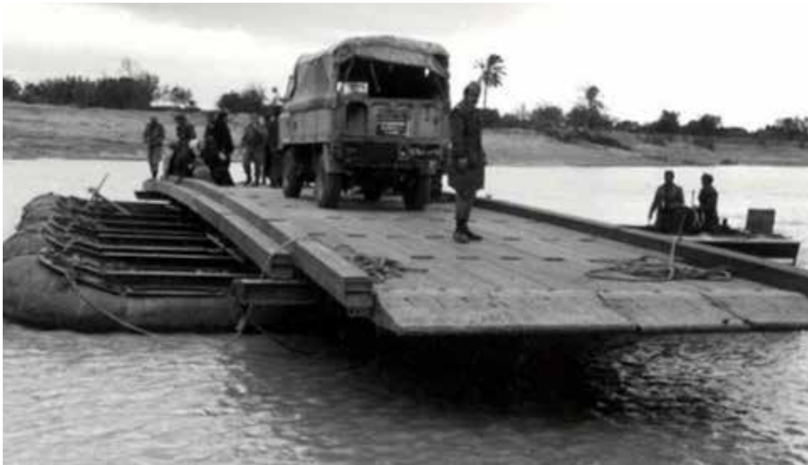
Compuerta sobre flotantes en el río Sed
