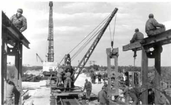
Premontaje Puente FFCC HG, véase detalle de la vía de 4 hilos
