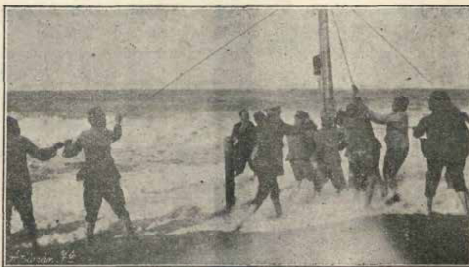
Trabajos para la construcción de un desembarcadero provisional en Sidi-Dris.
