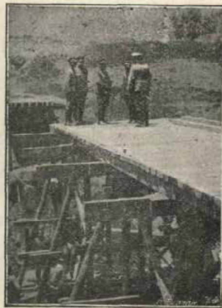
Puente viaducto en el camino de Anual.—Un aspecto de los trabajos durante la construcción de este puente.
