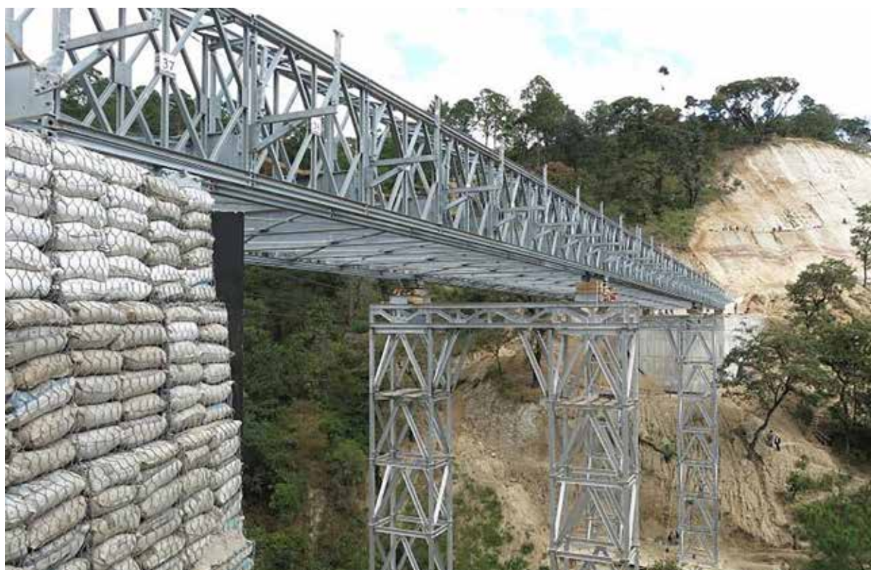
Puente modular de uso civil y militar de la empresa "Waagner Biro"
