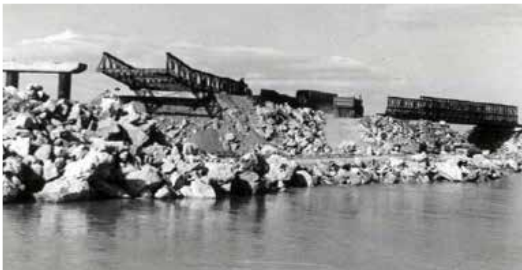
Primer puente Bailey lanzado y lanzamiento del segundo
