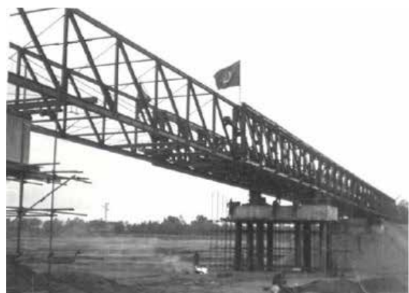
Lanzamiento puente HG FFCC
