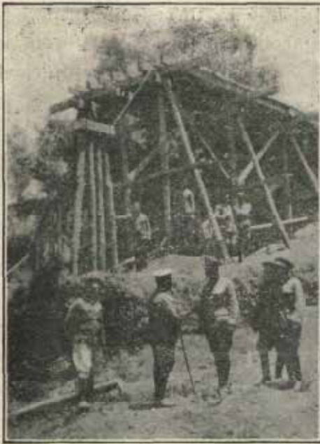
Puente viaducto en el camino de Anual.—El General Navarro felicitando al coronel López Pozas por la buena marcha de los trabajos.
