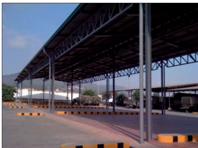
Vista de los nuevos y amplios hangares.
