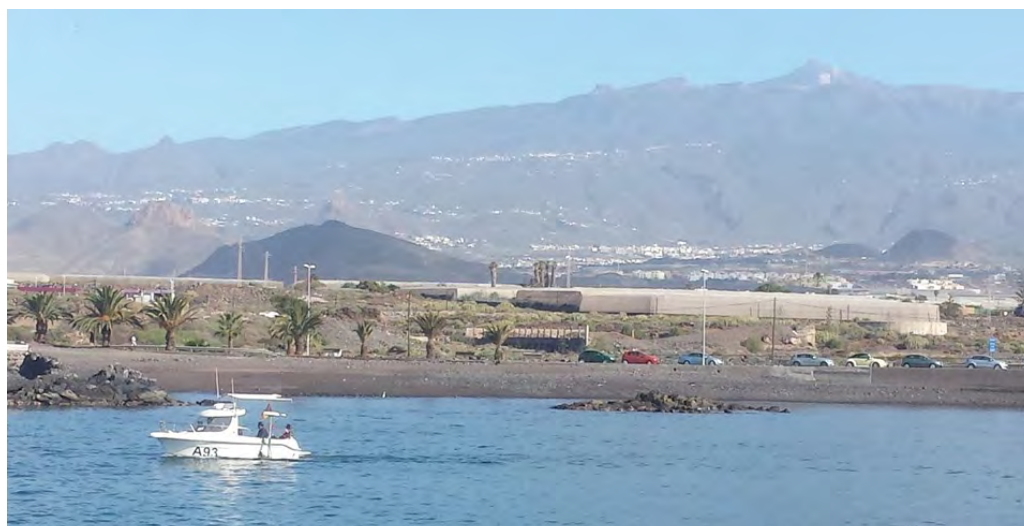
LHT Sondaleza trabajando en el puerto de Las Galletas (Tenerife)
