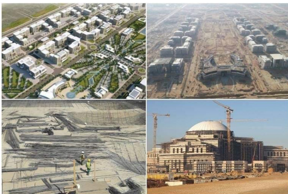
Figura 4. Construcción de la nueva capital administrativa de Egipto. Fuente. Disponible en: https://www.eltiempo.com/mundo/mas-regiones/las-fotos-de-la-faraonica-ciudad-que-se-construye-desde-cero-en-egipto-463918
