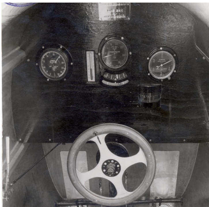
Banco WES para entrenamiento de vuelo sin visibilidad de pilotos en tierra, febrero de 1932.
