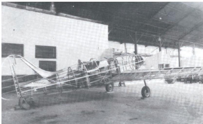
Fotografías tomadas en la factoría sevillana de la Hispano-Suiza en 1942, durante la construcción de la maqueta a escala 1:1 del D.600/HS-50.
