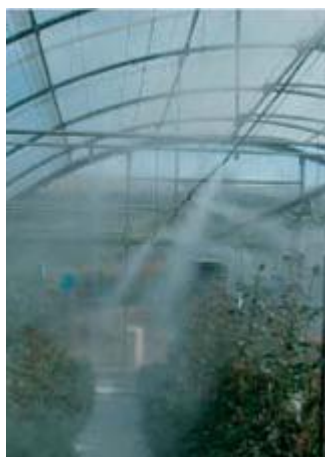
Figura 8. Sistemas de nebulización
