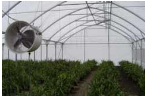
Figura 7. Ventiladores de flujo lateral
