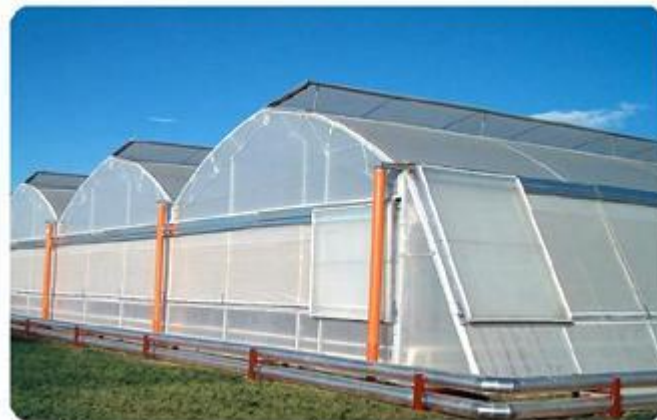
Figura 3. Invernadero en forma de Túnel
