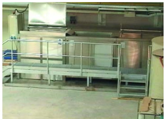
Instalación de limpieza de moldes.
