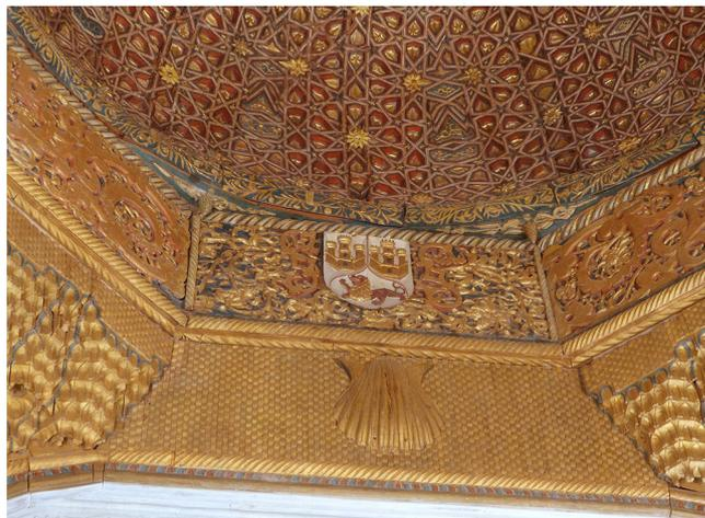
Figura 17. Vista general de las tablas de alicer, cubriendo el tambor octogonal con decoración heráldica y floral, y la banda de transición del octógono al círculo.
