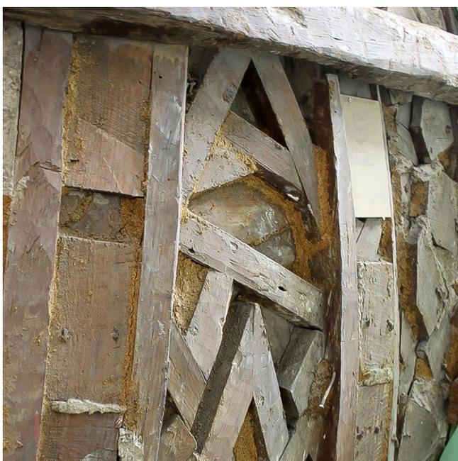
Figura 6. Detalle de del apeinazado de los paños, visible por el trasdós.
