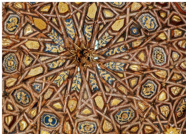
Figura 10. Zona de la clave de la cúpula vista por el intradós, con severas imperfecciones causadas por la discontinuidad de los camones.
