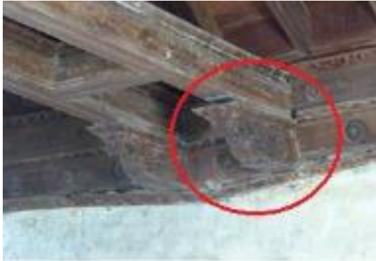
Figura 16. Descenso de canaleta bajo el tirante 2 (T2), en eje 2.
