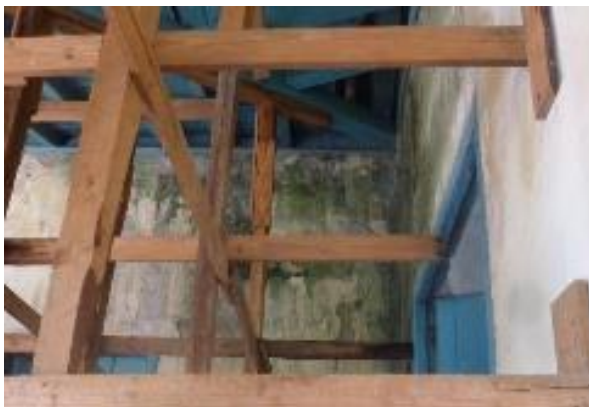
Figura 7 y Figura 8. Pátinas en muro de galería a eje 2 del Coro.
