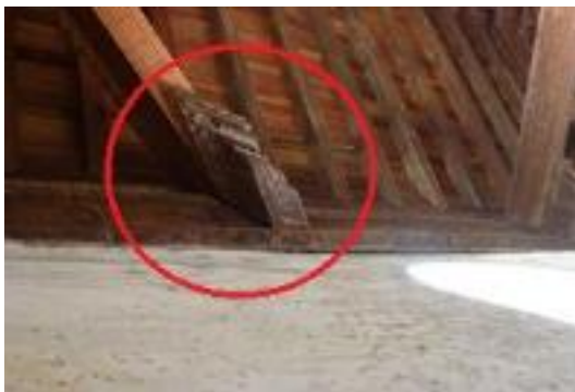
Figura 18 y Figura 19. Descenso de canaleta en esviaje (Ce7 y Ce8) bajo cuadrante 4 (Cd4).
