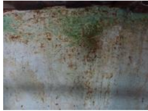
Figura 10. Pátinas verdes bajo arrocabe en el eje 2.
