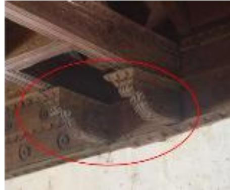
Figura 17. Descenso de canaleta bajo tirante 1 y 2 (T1 y T2), en eje 1.
