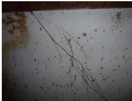
Figura 11. Raíces en eje A de plantas hospederas en la cubierta.
