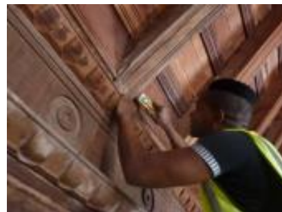
Figura 23. Medición de humedad superficial en elementos.
