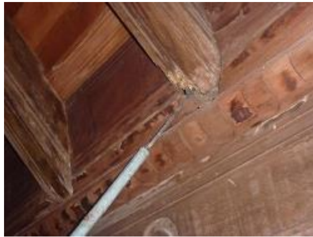
Figura 24. Sondeo de elementos de madera con punzón graduado.
