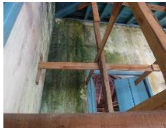
Figura 7 y Figura 8. Pátinas en muro de galería a eje 2 del Coro.
