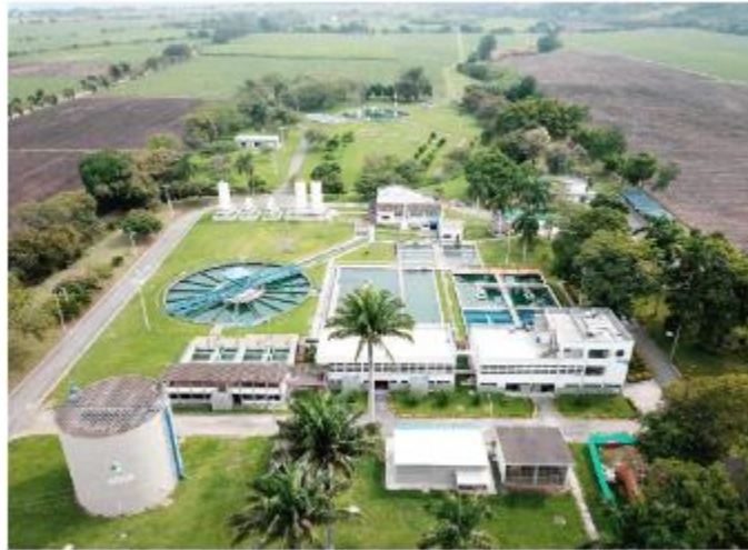
Imagen 5. PTAP – Aquaoccidente – rio Nima Ubicada en Barrancas Fuente: (AQUAOCCIDENTE S.A E. S. P., 2021
