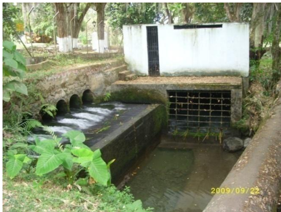
Imagen 3. Bocatoma de fondo municipio de Palmira captación de fondo
