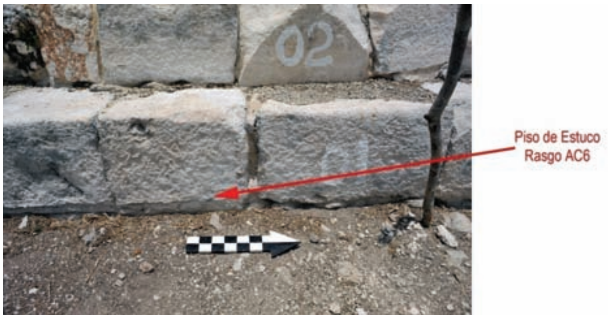
Figura 1.18. Piso de estuco Rasgo AC6, construido en la Etapa VIII. Todo lo que queda preservado de este piso es su capa de relleno de chich, unos restos de argamasa, y la huella del piso de estuco en el primer peldaño de la escalinata este de El Castillo.
