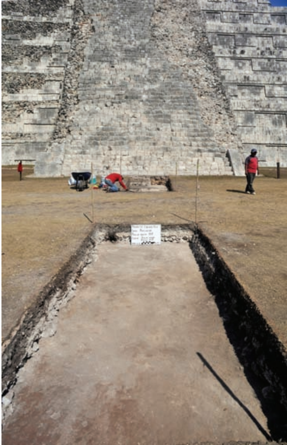
Figura 1.16. Piso de estuco Rasgo AC2, construido durante la Etapa V. Este piso cubrió todas las plataformas previas y expandió la plaza al este de la subestructura de El Castillo hasta la Columnata Oeste, dos estructuras que también fechan para la Etapa V.
