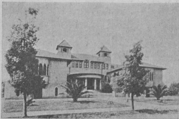
Abb. 3. Monroe-Schule, Stockton, Kal. Architekt L. S. Stone.
