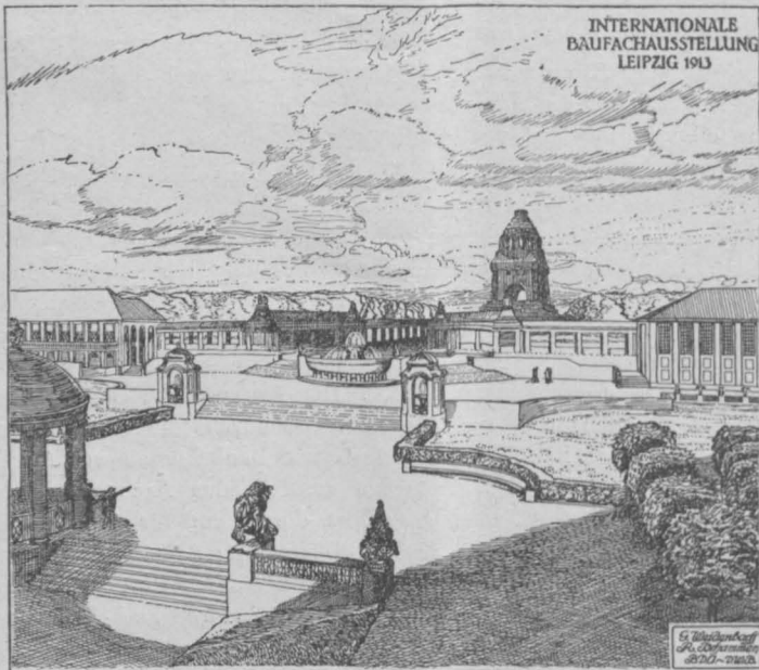
BRÜCKEN-ANLAGE DER STRASSE DES 18. OKTOBER
