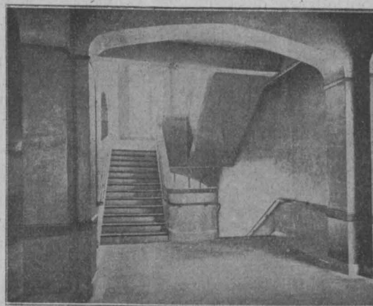
Abb. 1. Betontreppe der Hempstead-Schule, St. Louis, Mo. Architekt Wm. B. Ittner.
