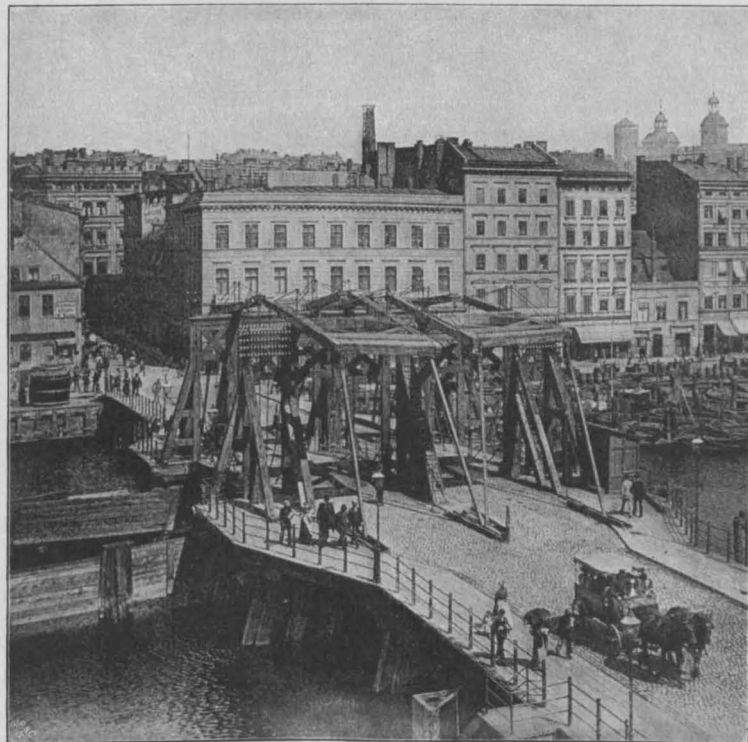
Abbildg. 3. Ehemalige Lange Brücke (jetzt Hansa-Brücke).
