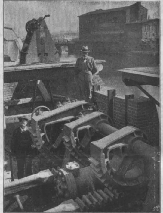
Abbildg. 10. Antriebsvorrichtung der Klappen.
