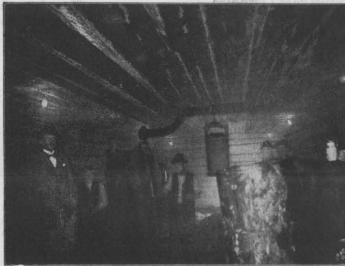
Abbildg. 9. Abschneiden der Pfähle der Klappenpfeiler im Senkkasten.
