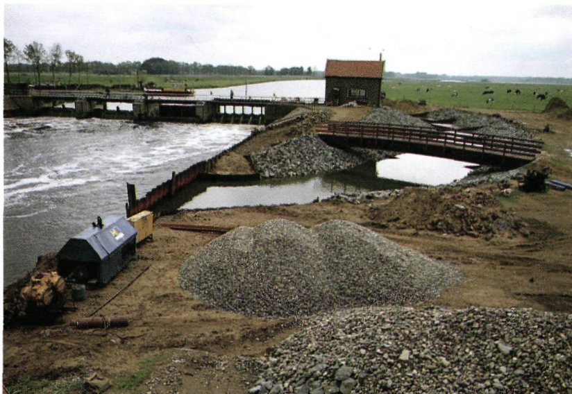
Figuur 14: Vistrap in aanbouw bij een stuw in de Overijsselsche Vecht
