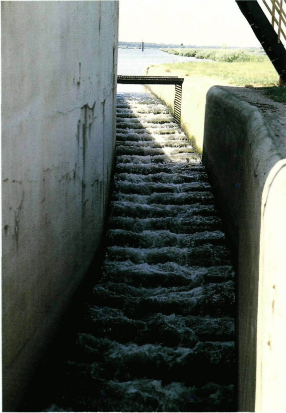
Figuur 6: Een denilgoot uit de jaren '20 bij de stuw in de Maas te Belfeld biedt optrekkende vis geen optimale passagemogelijkheden
