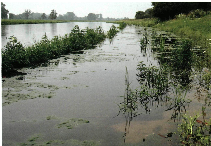
Figuur 13: Milieuvriendelijke oeververdediging tussen Mariënberg en Hardenberg langs de Overijsselsche Vecht: een glooiend talud met vooroeververdediging in plaats van een steile stortsteen oever
