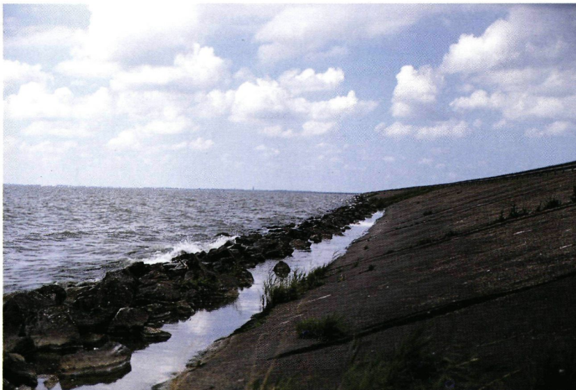
Figuur 3.6: Steile onbegroeide dijk (foto: Dienst Binnenwateren/RIZA)
