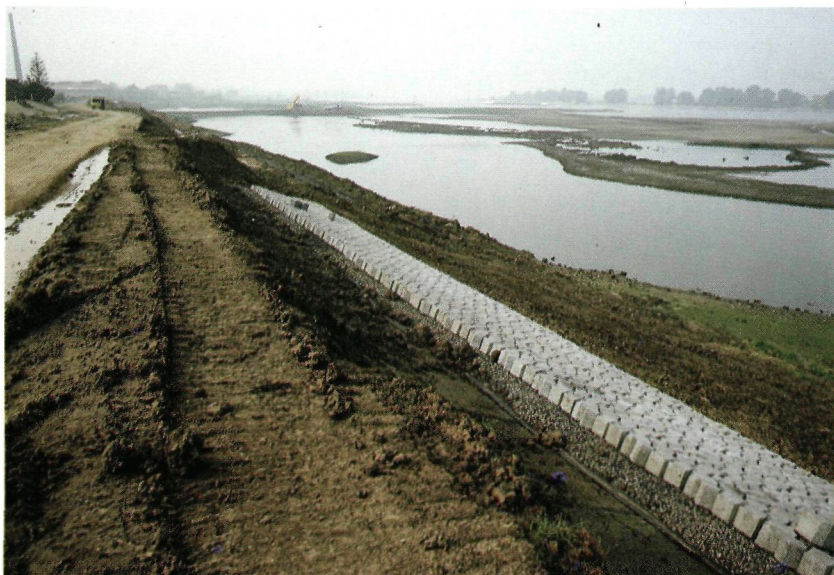
Figuur 16: Dijkverzwaringswerkzaamheden aan de Erlecomse dijk: de natuur houdt haar hart vast
