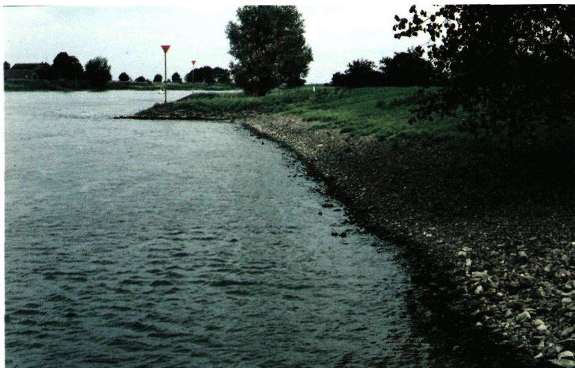
Figuur 5: Stortsteenoever langs de IJssel
