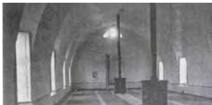
Figura 13: Nuevo Hospital de San Juan de Dios. Sala para pacientes con techos ojivales característicos del sistema Tollet y con estufas para calefacción. De Fotografías de Amador 15 . La Ilustración Española y Americana 1897.
