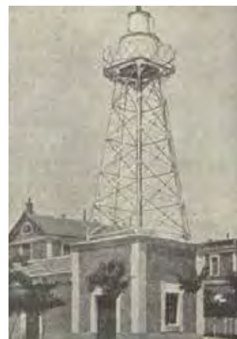
Figura 14: Nuevo Hospital de San Juan de Dios. Instalación hidroterápica inaugurada en 1900, financiada con el legado de Alejandro Bacqué 22 . Nuevo Mundo (Madrid) 1900.
