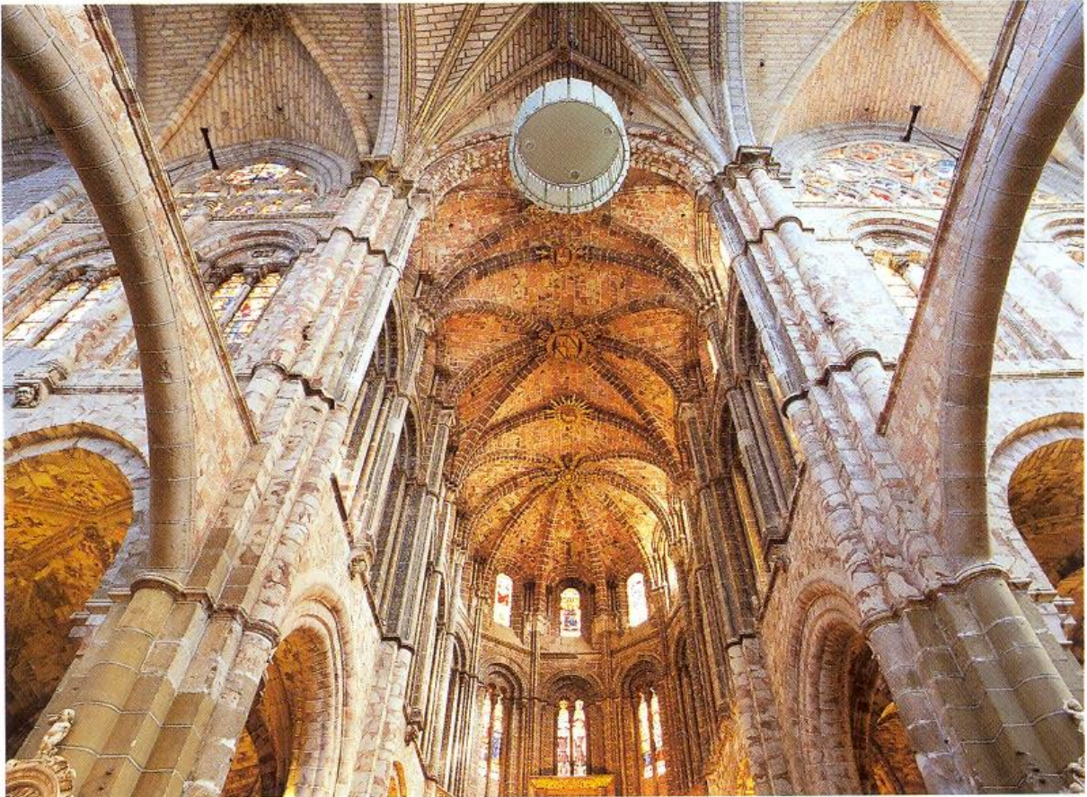
Bóveda de la cabecera y arcos de entibo en el crucero (José Luis Gutiérrez Robledo)
