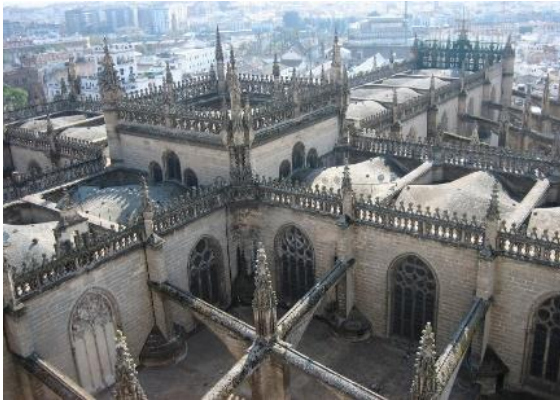
06 catedral de Sevilla. Perpiaños visibles sobre la cubierta 5
