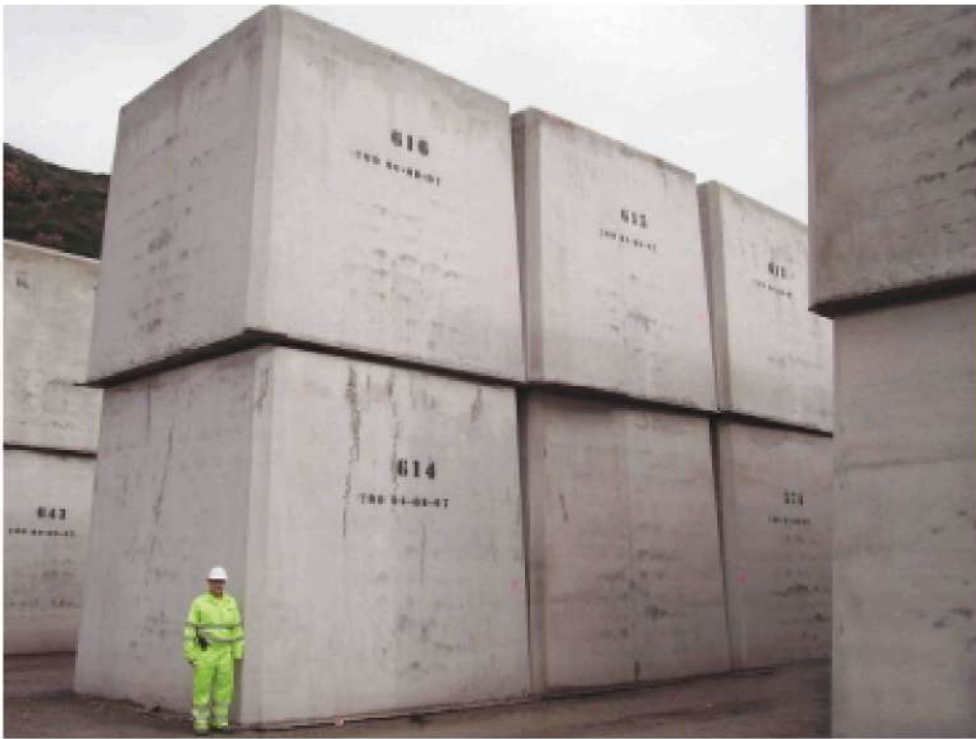
FIGURA 8. Bloque de 200 t en Cabo Torres, Gijón (Dn50 = 4.40 m). Abril 2009.
