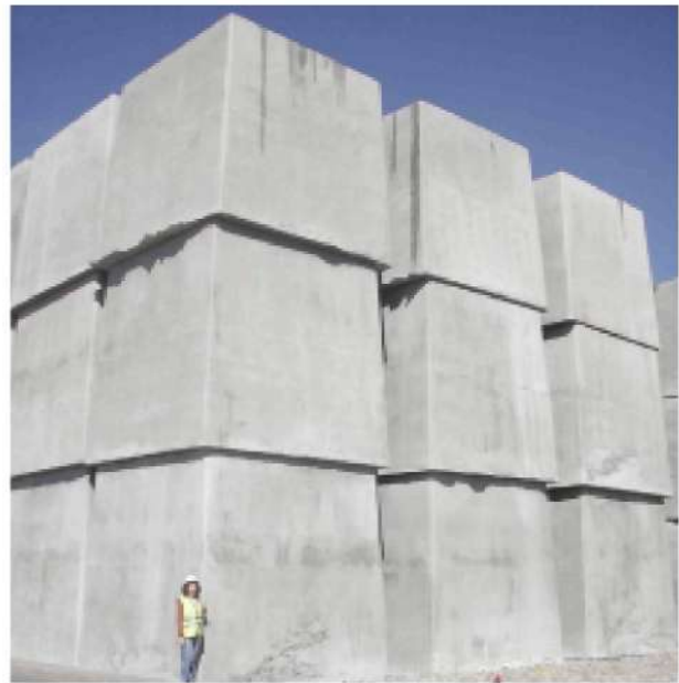
FIGURA 1. Cubos de 150 t en flanera. Punta Langosteria. A Coruña. Octubre 2008.
