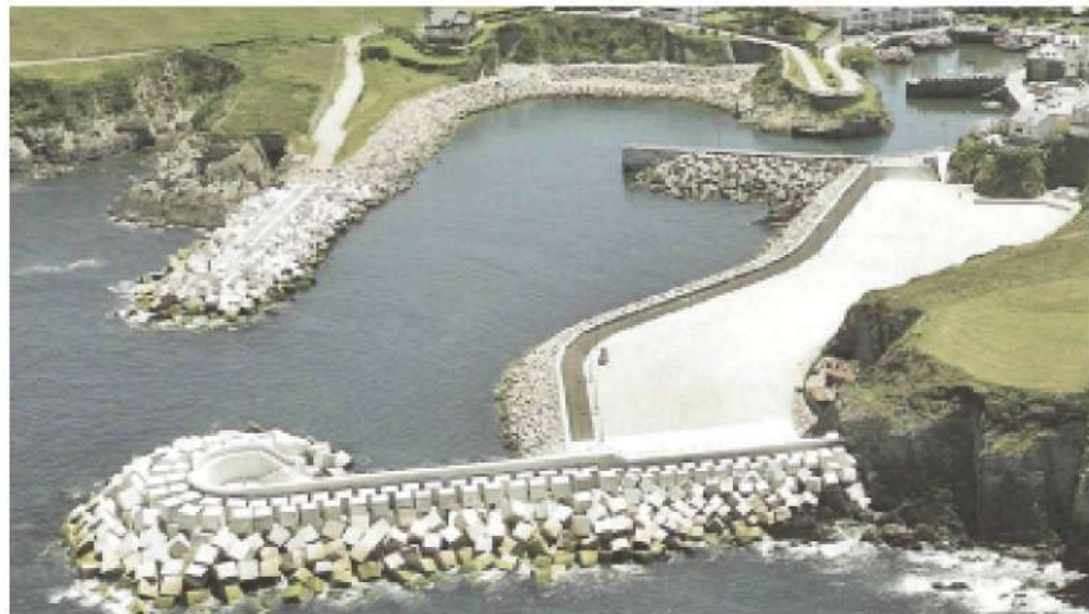
FIGURA 2. Ampliación del Dique de Puerto Vega, Asturias.
