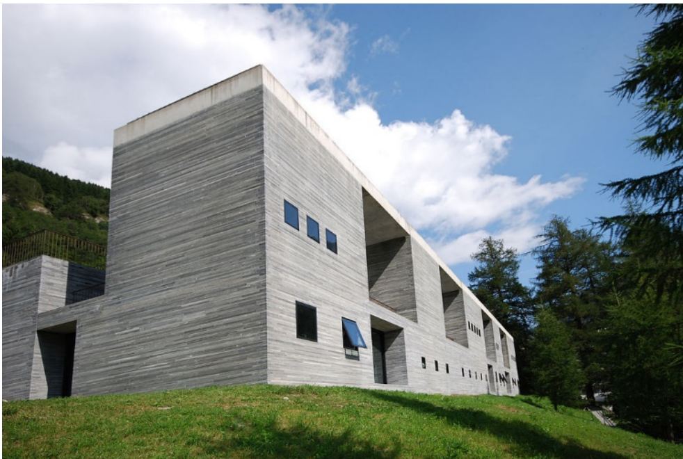
Fig. 67: Termas de Vals. Vista general exterior. Peter Zumthor.
