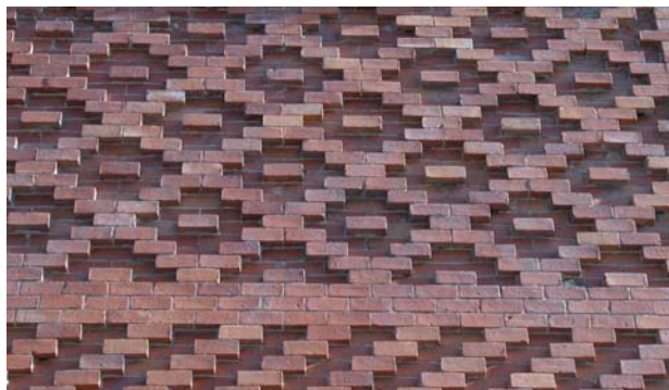
Figura 9: Panel de rombos con aparejo a tizones.
