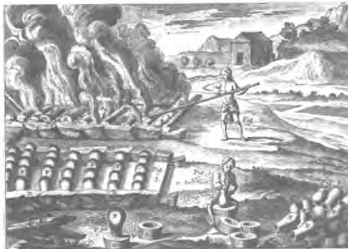
Extracción de azogue por el método de las ollas (M. Goussiers, 1768).
