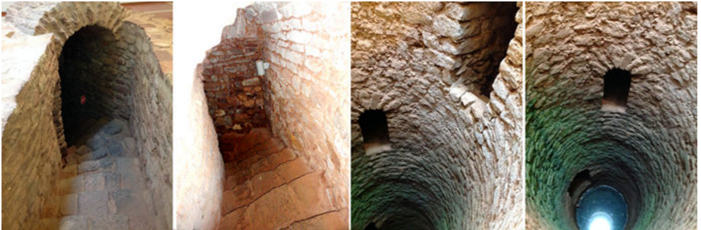
❶ Escaleras que rodean el pozo. ❷ Por las que se accede para tomar el agua. ❸ A lo largo de la escalera hay unas ventanas de medio punto para acceder a sacar el agua. ❹ Según la altura del agua hay que bajar más o menos.
