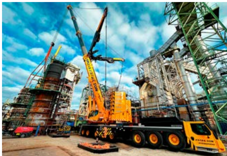
La grúa todoterreno Liebherr LTM 1650-8.1 de Grúas Estación se estrena en la refinería de La Coruña, Galicia, realizando el reacondicionamiento de depósitos que pesaban 80 toneladas cada uno, aproximadamente.
