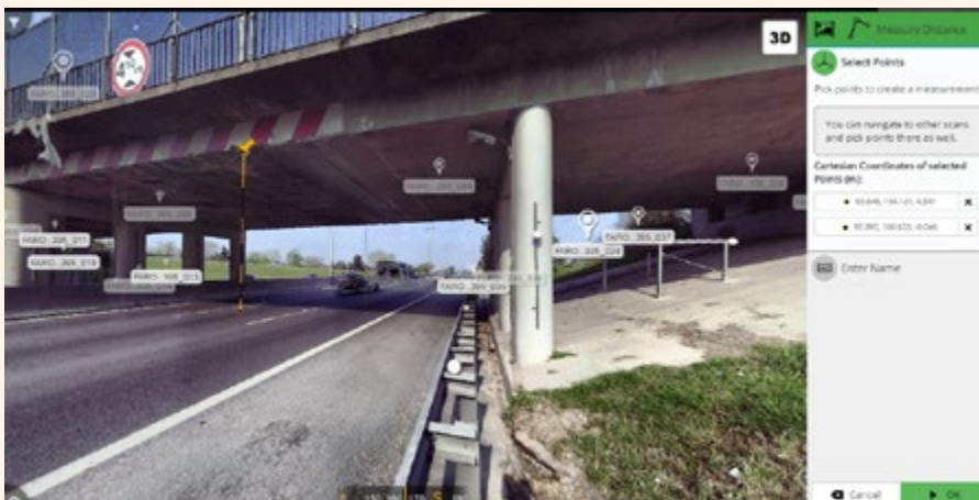
Figura 2 – Vista capturada desde la Posición 32. Se observa la medición de la altura libre de paso a través del visualizador de la estructura escaneada en 3D.
